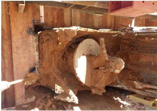
図-20 機械掘削による刃口到達状況
