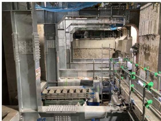
写真-9 鉄鋼框新設後
