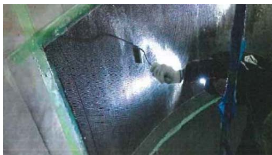
写真-2 繊維シート接着工施工状況
