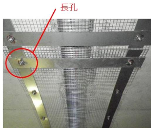
図-2 当て板工法の施工例
