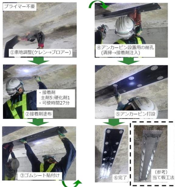
図-9 ゴムシート工法施工手順
