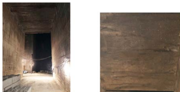
図-10 支保工を削除した大谷採石地下空間入口部(左図)とその拡大部(右図)
