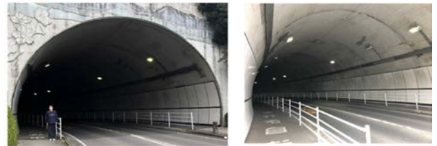
図-5 アンケートで用いたトンネルの写真
