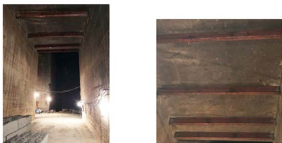
図-9 大谷採石地下空間入口部の支保工(左図)とその拡大部(右図)
