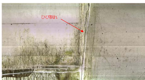
図-5 検証実験で撮影した変状可視画像
