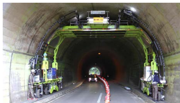
写真-5 走行式ガントリーフレーム型点検システムによる点検状況
