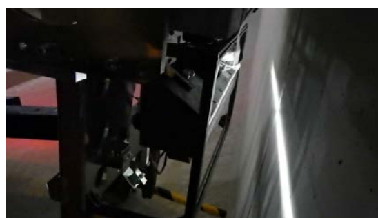
写真-4 コンクリートに照射した白色LEDスリット光
