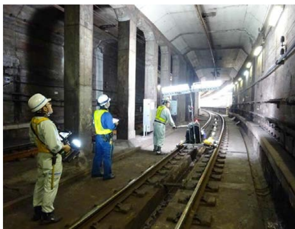
写真-1 トンネル検査
