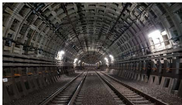
写真-10 トンネル上部
