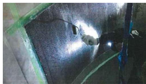
写真-2 繊維シートの施工状況
