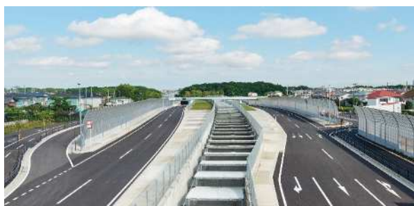
写真-1 国道 298 号と掘割スリット上部
