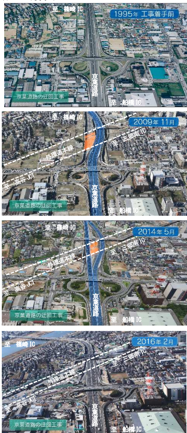
写真-5 京葉道路の迂回状況
