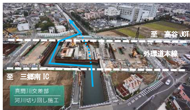
写真-3 真間川交差部
