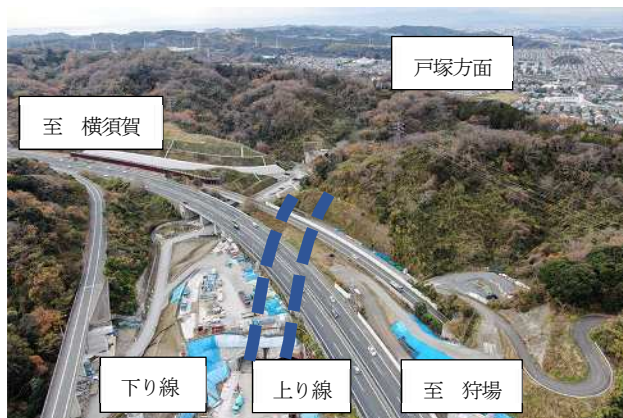
写真-1 現場上空写真
