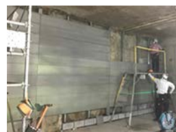
写真-5 複壁施工状況
