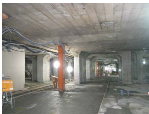
写真-3 スケルトン化完了時の状況
