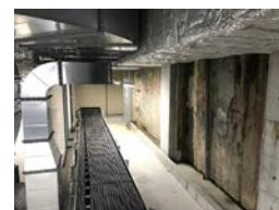
写真-6 設備室の状況
