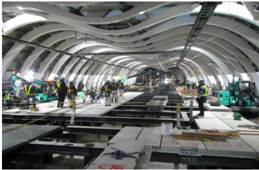
写真-3 新ホーム構築状況
