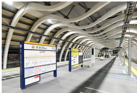
写真-7 駅設備設置完了後
