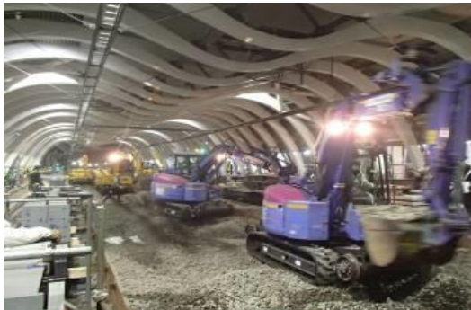
写真-4 バラスト撤去作業（開口投入）
