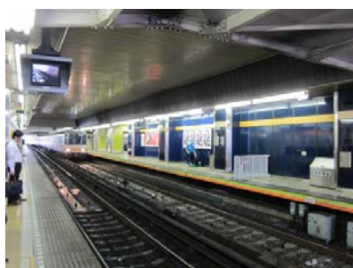
写真-1 銀座線渋谷駅の現況ホーム
