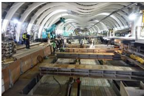
写真-6 かんざし桁撤去状況
