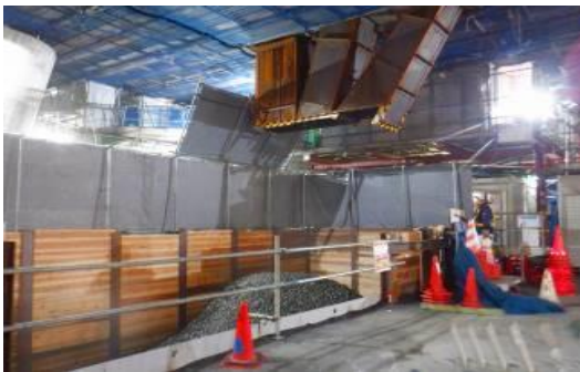
写真-5 バラスト撤去作業（本設桁下）
