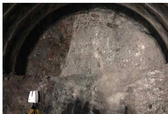
図-2 リアルタイム計測状況（掘削直後）
