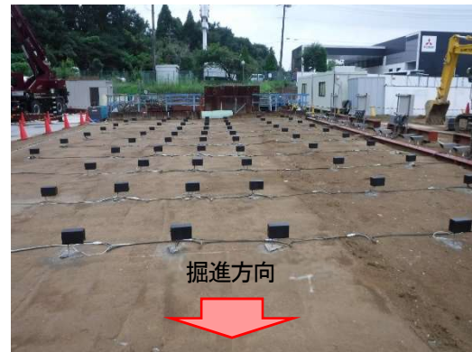
図-12 地表面変位計測状況
