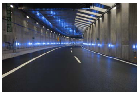
写真-10(a) ペースメーカーライトの点灯状況 (速度低下時：青色流れ点灯)
