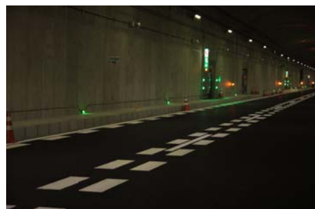
写真-4(a) 足元灯の設置（点灯）全景
