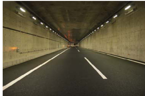
写真-8(a) 視線誘導灯の点灯状況（平常時：黄色点灯）
