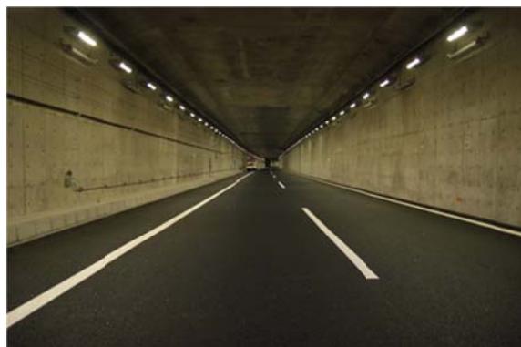
写真-2(a) 警告灯照明の点灯状況（平常時：消灯）
