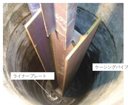
写真-3 覆工支持杭建込み状況
