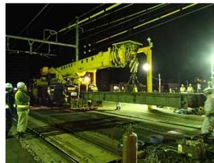
図-9 既設桁撤去状況
