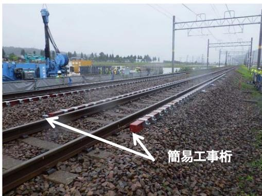
図-12 簡易工事柵設置状況
