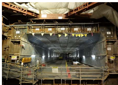
写真-4 躯体内部掘削完了
