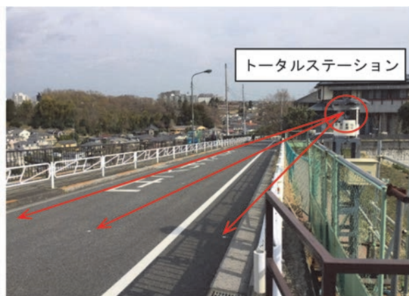
写真-1 トータルステーションを用いた自動計測システム
