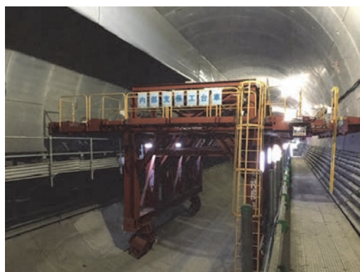
写真-2 内部支保工台車
