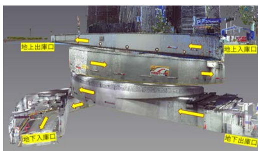
図-2 南入庫路（北西から南東へと見通す）
