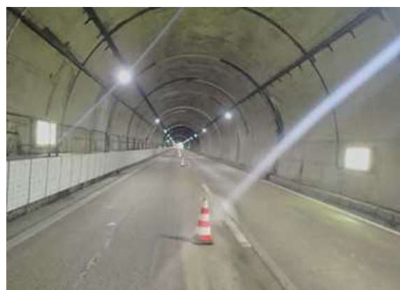
写真-8 覆工表面洗浄後の状況
