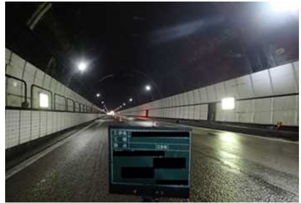
写真-4 覆工表面洗浄前の状況
