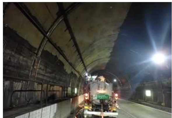
写真-5 覆工表面洗浄状況（走行車線側）
