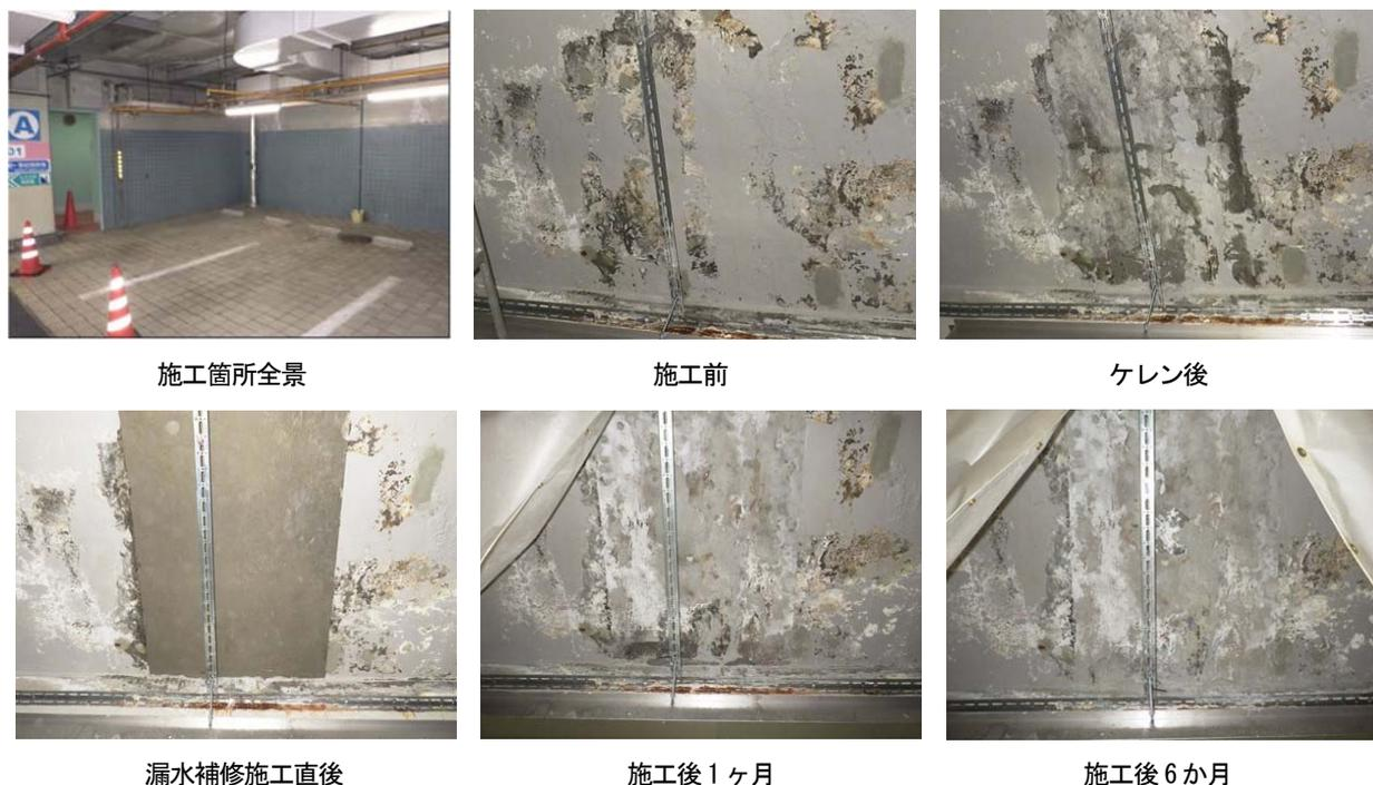
図6 地下街駐車場天井部での試験施工結果
