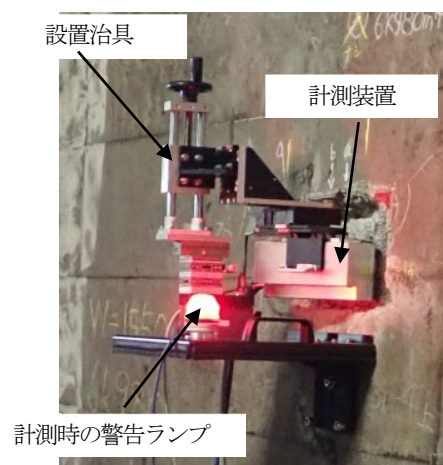
図-6 X線回折法による計測状況
