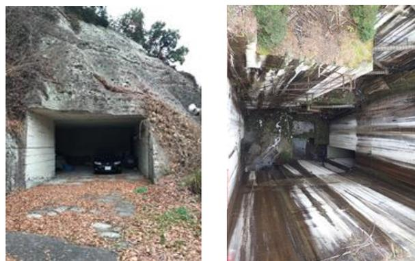
図-1 大谷石採石場の入口の例(左：矩形断面の横坑，右：矩形断面の立坑)
