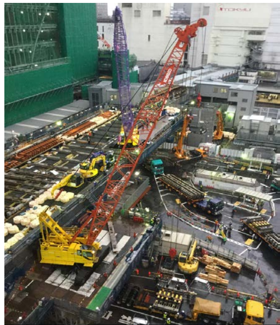
写真-3 道路区間の作業状況
