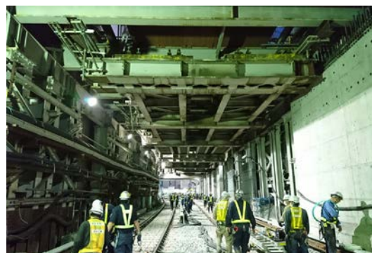
写真-5 扛上後の状況
