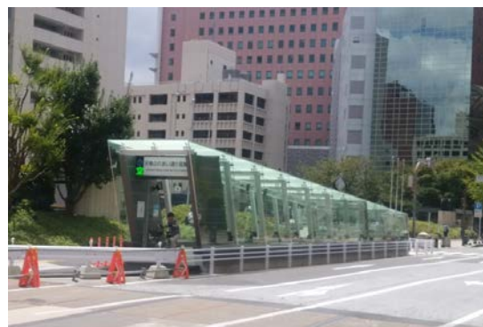
図-8 駐輪場出入口
