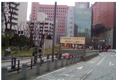
図-7 仮設車路出入口（着工前）
