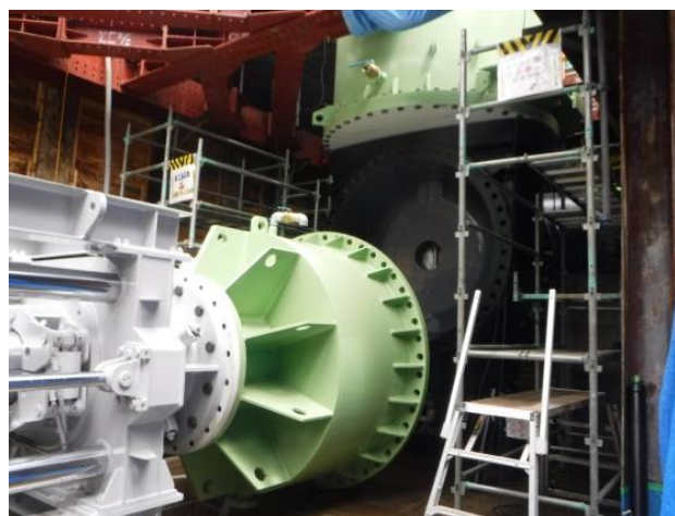
写真-9 既設管穿孔状況
