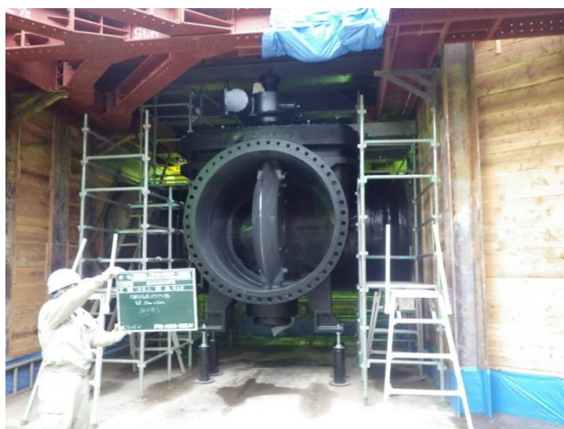
写真-8 バタフライ弁取付状況
