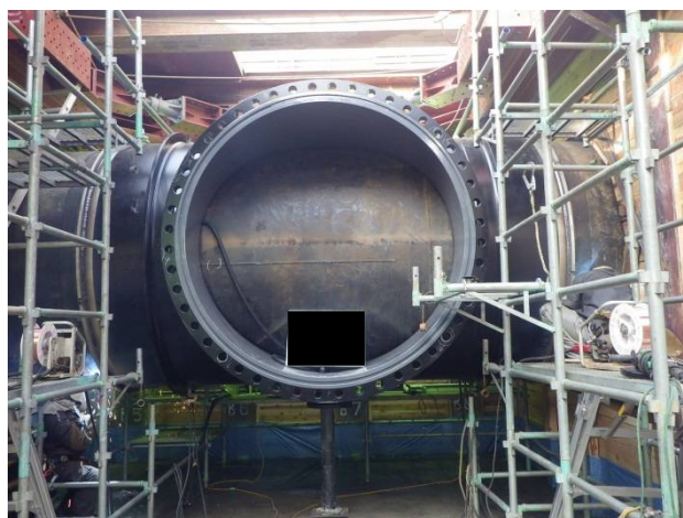
写真-7 割T字管取付状況
