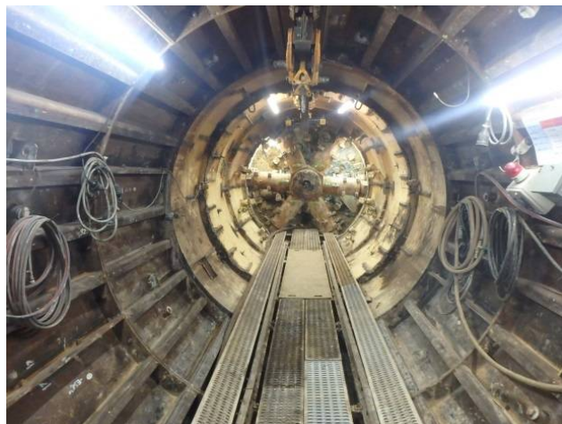
写真-6 第3工区側から見た第2工区シールドマシンカッター部
