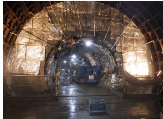
写真-3 凍土面防熱防熱材設置状況
