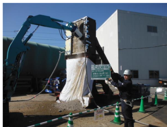
写真-2 凍土掘削実験状況
