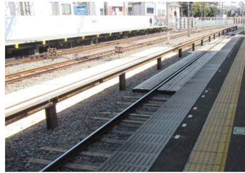
写真-2 桁受け設置状況
