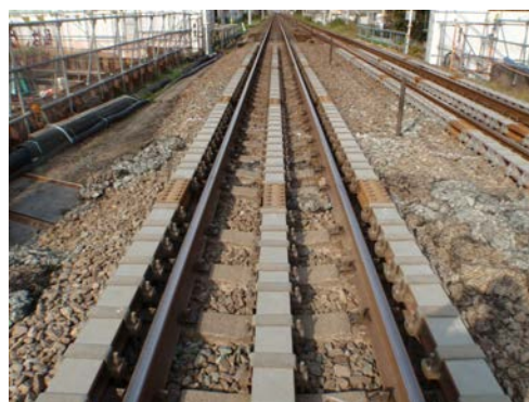
図-1 簡易工事桁の設置状況
