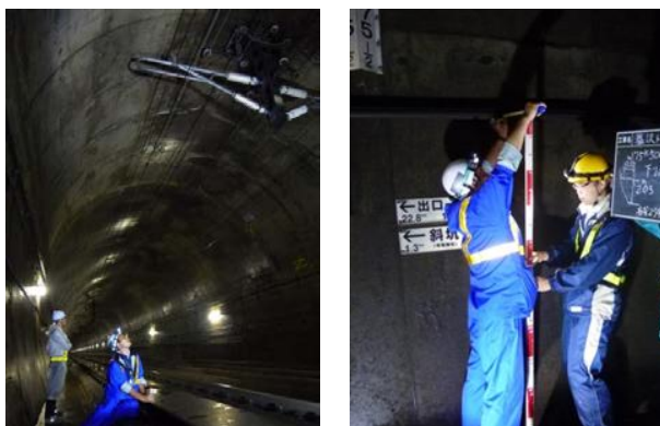
図-8 付帯物調査状況
