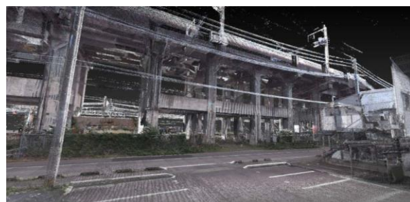
図-4 線路外の点群データ
