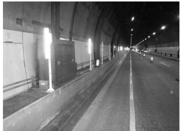
図-14 中野長者橋に設置されたエスコートライト
