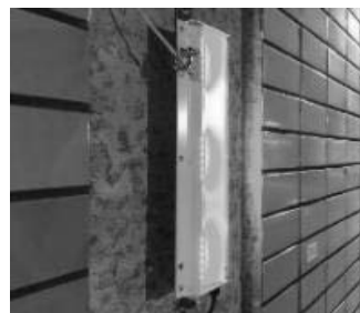
図-5 東京港トンネルに設置したエスコートライト
