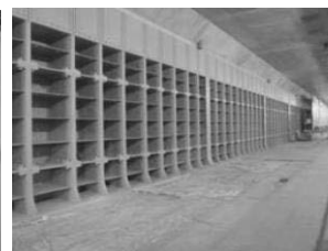
図-35 鋼殻セグメント設置完了
