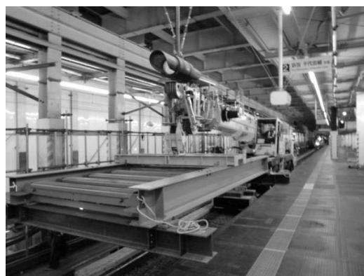
図-16 下北沢ホーム内の工事桁化工事
