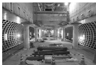
図-21 シールド切上げ完了
