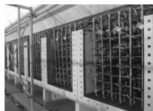
図-34 中床版接合施工状況
