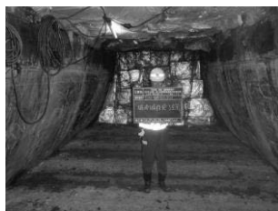
図-24 シールド間掘削状況
