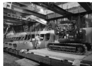
図-33 鋼殻セグメント設置状況
