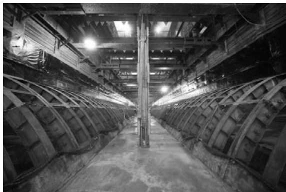
図-17 シールドスキムプレート撤去完了
