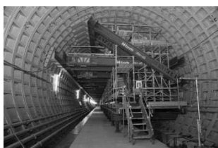
図-20 シールド変形防止工
