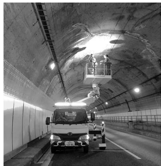
図-4 近接目視点検実施状況
