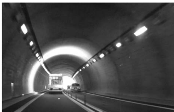
図-5 覆工表面撮影状況の例
