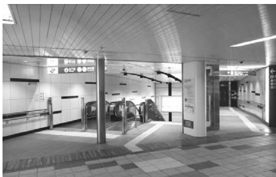
写真 - 13 西口中央地下歩道と地下鉄東西線連絡施設接続部
