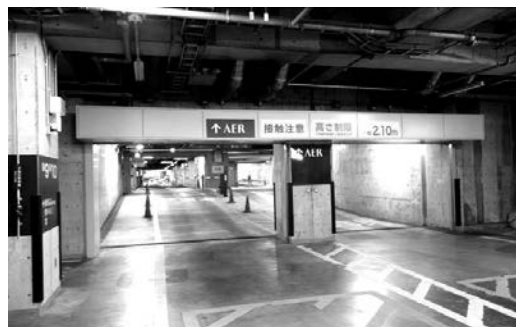
写真 - 3 再開発ビル駐車場連絡公道地下横断車路
