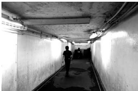
写真 - 1 名掛丁地下道
