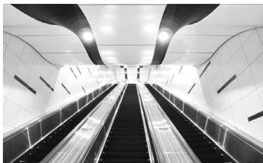
写真 - 9 東西線仙台駅エスカレータ
