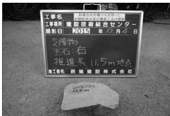
図-18 切断された支障物（玉石）
