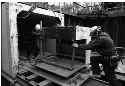
図-20 分割した刃口の引き戻し
