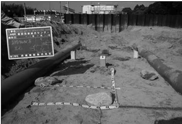
図-11 支障物の埋設状況
