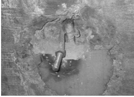
写真-6 仕上げ材定着部の状態
