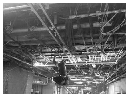
写真-1 上：天井部解体 下：設備等吊り補強状況
