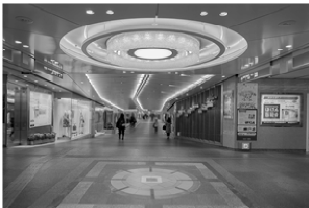
写真-3 軽量天井板取り付け完了（耐震改修工事完了）
