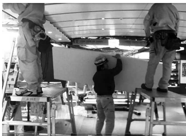
写真-2 軽量天井板取り付け状況
