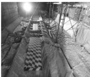
写真4-3 鉄道施設物防護状況
