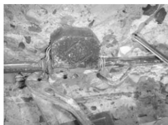
写真 4-6 犠牲陽極材取付状況
