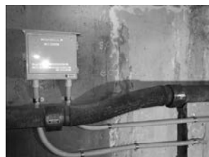
写真5-1 配流端子、照合電極、計測ボックスの設置
