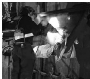
写真4-4 側壁はつり状況
