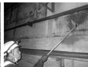
写真 4-2 打音・目視調査状況
