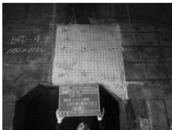
写真4-7 FRP格子筋取付け状況
