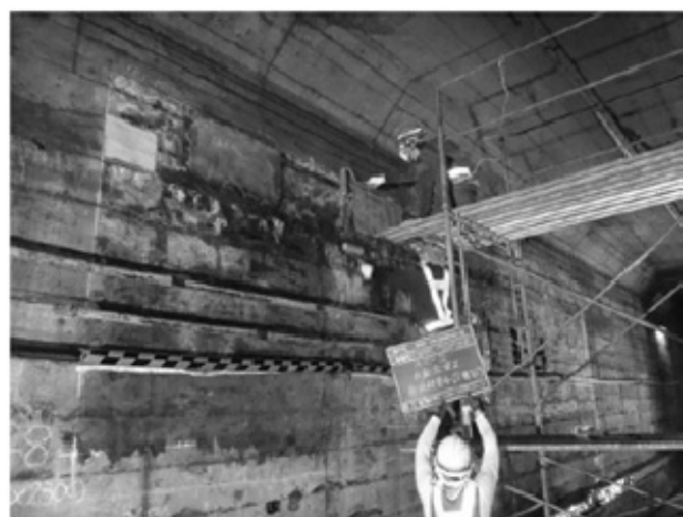
写真4-8 表面含浸材塗布状況写真
