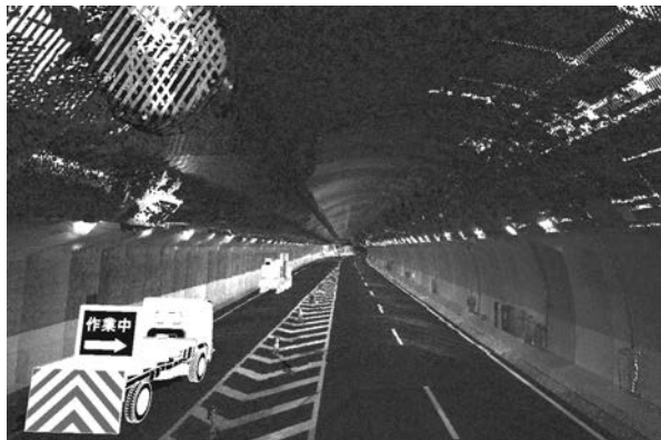
図-8 点群とCAD車両による点検シミュレーション
