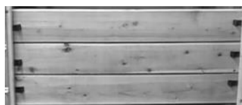
写真-2 止水板 (木製)
