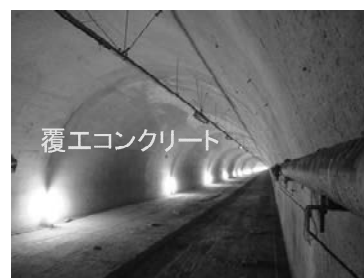
写真-1 小断面トンネルの内観（NATM施工，二次覆工有）
