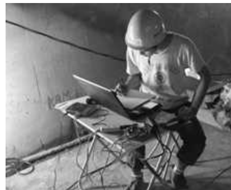
写真-6 トンネル内における計測状況
