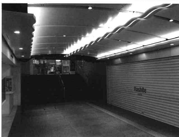
写真-6 通路天井のリニューアル状況（上：撤去前 下：撤去後にモックアップとして天井板を設置）
