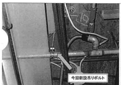
写真-5 通路天井部の吊り補強完了状況
