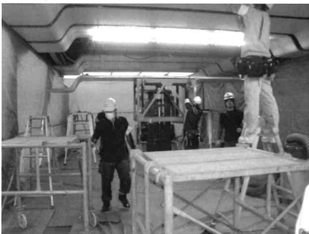
写真-3 通路天井の解体状況
