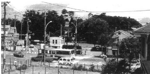
写真-1 着手前状況（手前が青梅街道）
