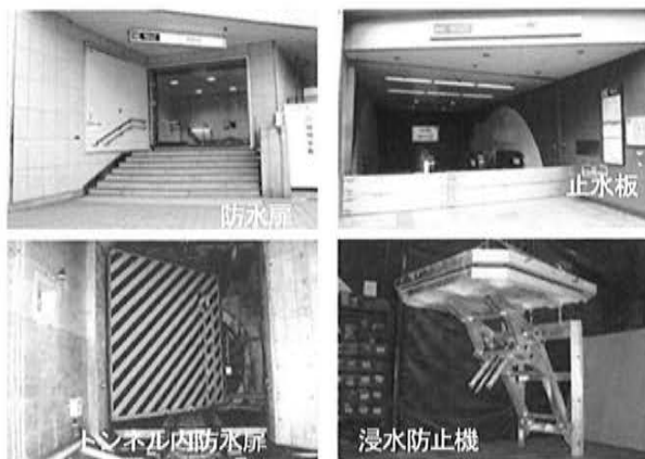
写真-4 東京地下鉄の浸水対策
