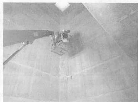
写真-1 健全度調査状況
