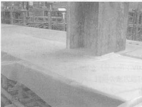
写真-3 目粗し処理シート設置
