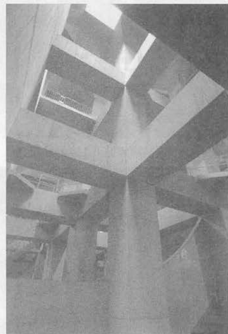
写真-11 3号調節池（地下3階）
