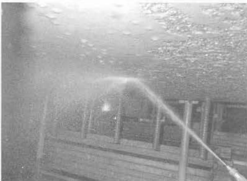
写真-4 高圧水による洗い出し
