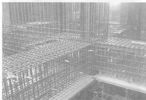
写真-7 柱・梁接合部の実配筋状況
