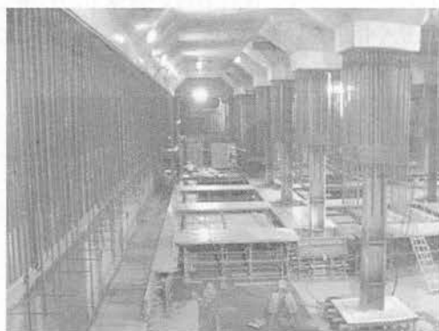
写真-6 実際の地下1階鉄筋組立
