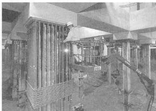
写真-5 柱筋組立状況（高所作業車使用）
