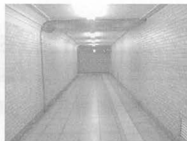
写真-4 「幻の新橋駅ホーム」活用位置現況
