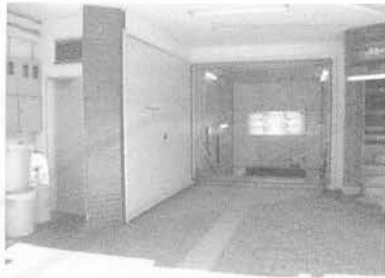
写真-6 防水扉の状況
