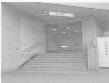
写真-4 出入口の嵩上げ状況
