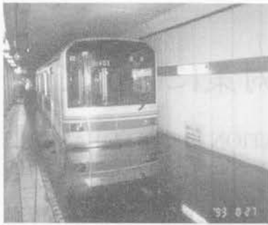
写真-1 赤坂見附浸水事例
