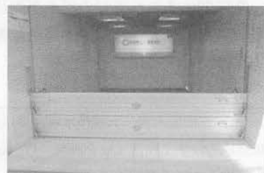
写真-5 止水板（2段）の設置状況
